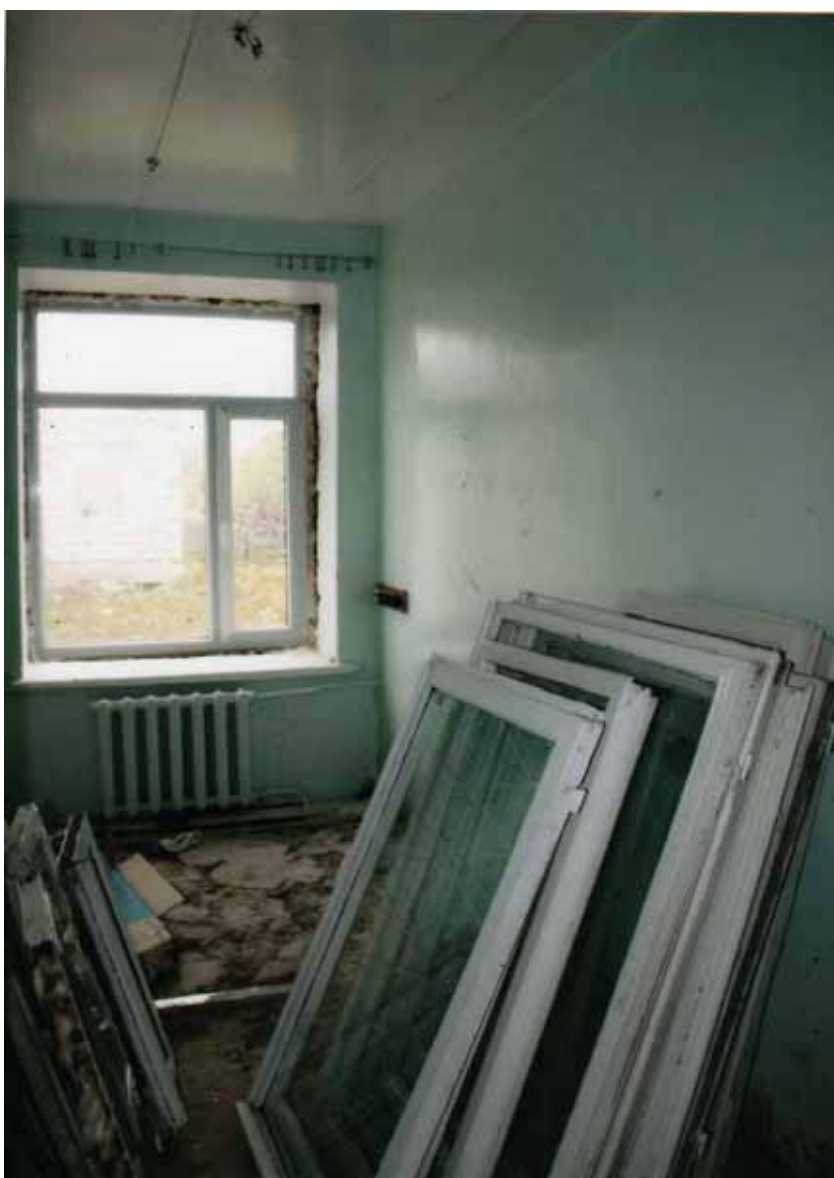
Travaux réalisés en mai 2008 : remplacement des fenêtres.
